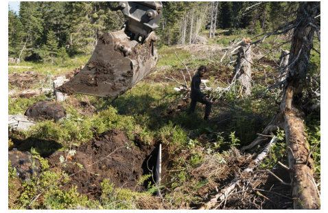
Die Investitionen in die Wiedervernässung kommen zum Grossen Teil dem regionalen Gewerbe zugute. Foto: Sebastian Eppler
