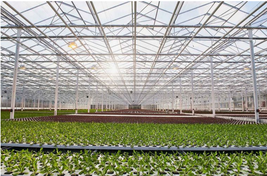
Gewächshaus mit einer erneuerbaren Heizung. Foto: Linda Marugg
