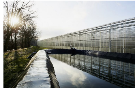
Regenwasserbecken als Speicher für 1'800 Kubikmeter Regenwasser zur Bewässerung von Salaten. Foto: Forster Gruppe
