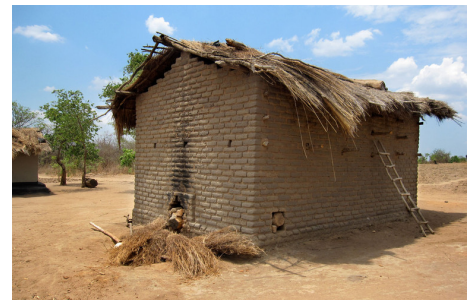
Die traditionellen Trocknungsanlagen verbrennen Holz sehr ineffizient.
