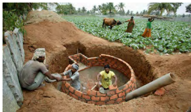
Inde: Construction de centrales de biogaz
