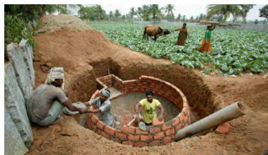
India: Costruzione di digestori di biogas
