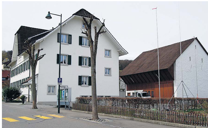
Auf der Wartebank: Erweiterung und Sanierung des Altersheims. SL
