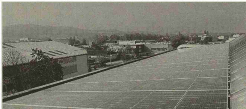
Pro Jahr produziert die O. Kleiner AG rund 42000 Kilowattstunden Solarstrom selber.
