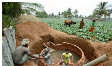
Indien Bau von Biogasanlagen
