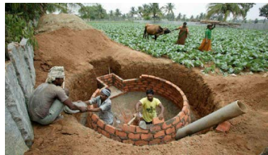
Indien Bau von Biogasanlagen
