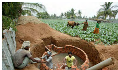
Indien Bau von Biogasanlagen
