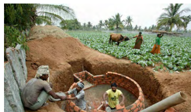
Inde Construction de centrales de biogaz
