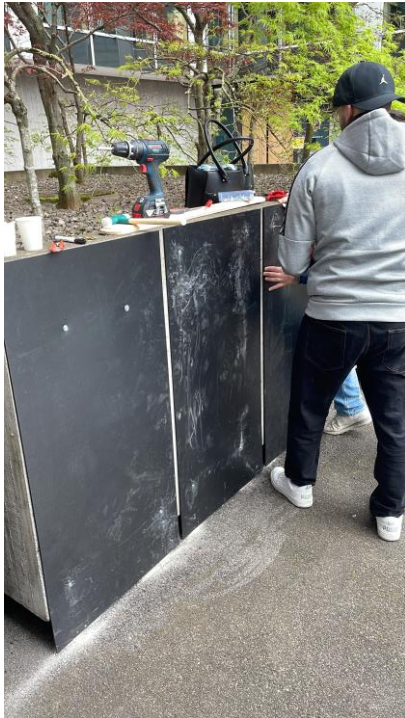
Bild 1: Installation von Panels Am 19.04.2023
