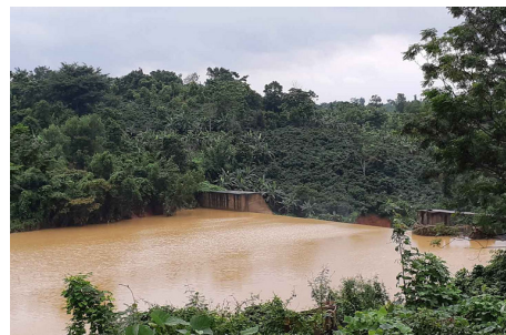
Un barrage de plus de quatre mètres de haut retient l'eau dans un réservoir. Foto: myclimate
