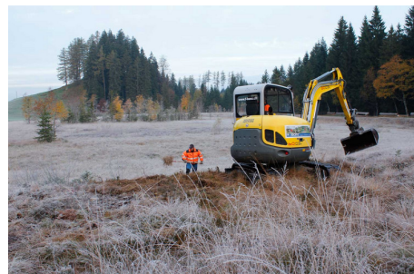
Les investissements dans la remise en eau. Photo: Beck und Staubli
