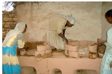
En travaillant ensemble, les femmes érigent la partie supérieure du four à mogogo avec des carreaux préfabriqués.
