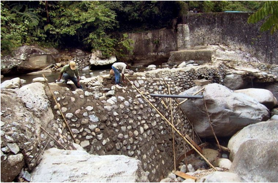
Reconstruction du barrage historique avec des matières premières locales.
