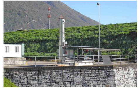
Vue arrière de la torche, au fond la colline de la décharge Pizzante 2.
