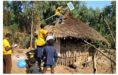
Installation d'un système solaire domestique dans le village.
