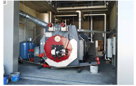
Installation de pyrolyse pour la production de carbone végétal (photo et copyright: Peter Fröhlich)
