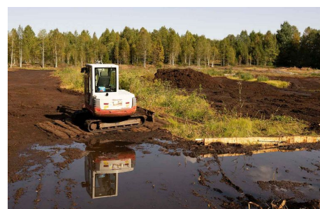
Lors d'une renaturation, on effectue des travaux pour fermer définitivement les tranchées de drainage. Photo: myclimate
