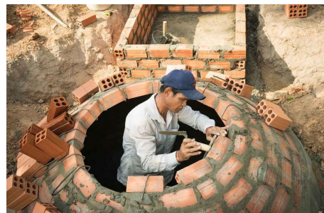
Construction d'une centrale de biogaz en tuile et en argile.
