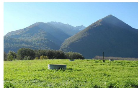
An der Oberfläche der Deponie sind die vertikalen Gasbrunnen erkennbar: Mit Hilfe der Gasbrunnen wird das Deponiegas gefasst und über zwei Sammelleitungen zentral zusammengeführt.
