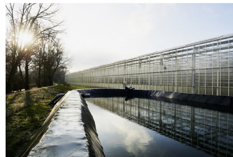
Bacino d'acqua piovana in funzione di serbatoio con 1 800 metri cubici di acqua per l'irrigazione delle insalate. Foto: Gruppo Forster
