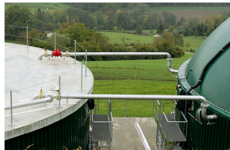
Un tetto in membrana doppia sul serbatoio di fermentazione e un deposito finale per i residui di fermentazione assicurano che il metano non fuoriesca (foto: Fondazione Svizzera per il clima).
