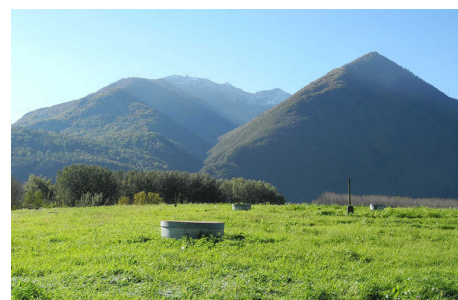
Sulla superficie della discarica sono visibili i pozzi di gas verticali: con l'ausilio dei pozzi il gas della discarica viene accumulato e raccolto centralmente tramite due apposite condutture.
