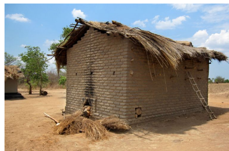
I tradizionali impianti di essiccazione bruciano la legna in modo molto poco efficiente.
