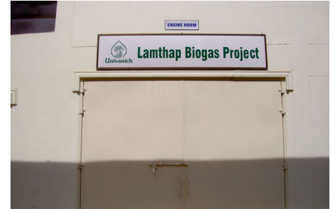
Sala macchine del progetto biogas dell'azienda Univanich.
